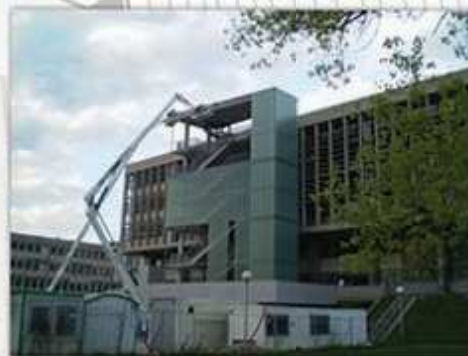
Chantier de réhabilitation 2007-2009
