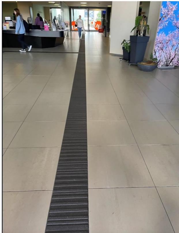
Photo de la bande podotactile reliant les deux entrées et les autres
