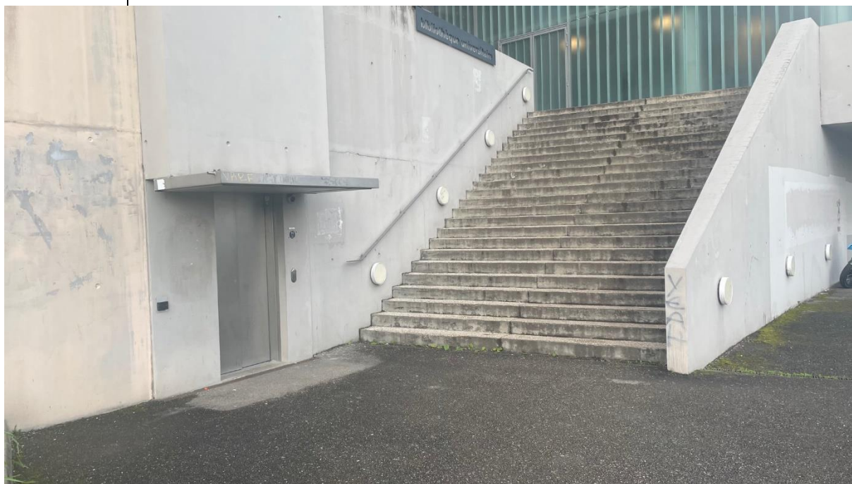
Photographie de l'ascenseur du côté du tramway et des escaliers.
