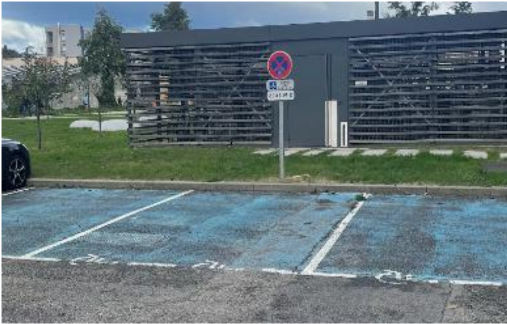
Photographie du parking présentant les emplacements réservés aux personnes en situation de handicap.
