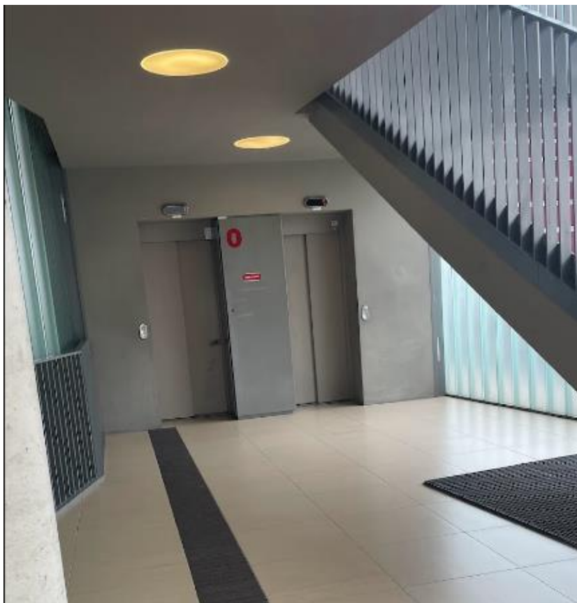
Photographie des bandes podotactiles guidant vers les ascenseurs.
