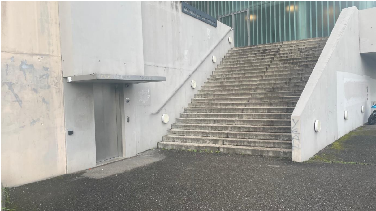
Photographie de l'ascenseur du côté du tramway et des escaliers.
