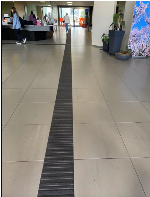
Photo de la bande podotactile reliant les deux entrées et les autres espaces
